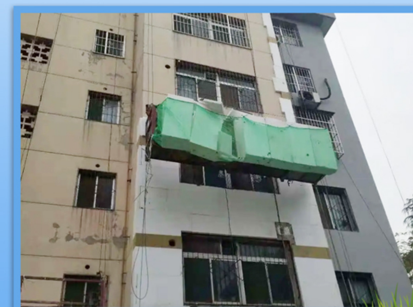
外墙保温改造项目
