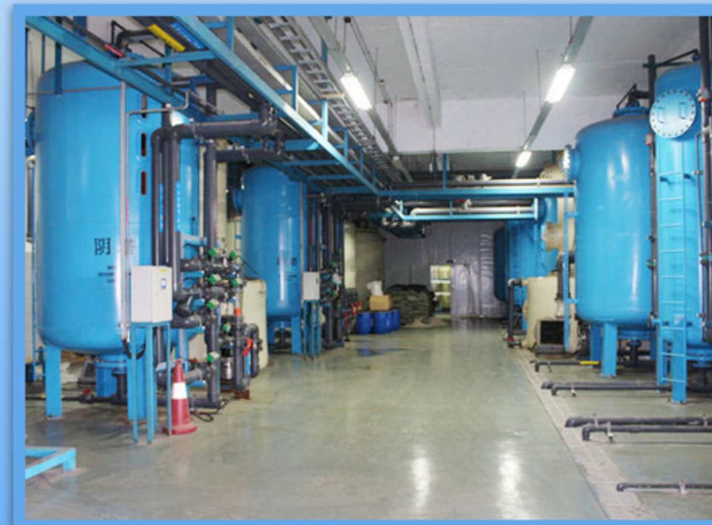
节水改造项目
